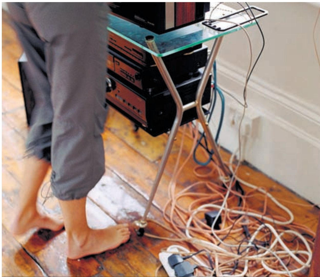
In diesem Kabelsalat wimmelt es nur so von elektromagnetischer Strahlung. Ob das schädlich ist, ist umstritten.
